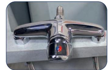
Installation du mitigeur et des 2 tuyaux sur la baignoire. Raccorder les flexibles sur le robinet en attente sur le mur à 40 cm du sol environ.
